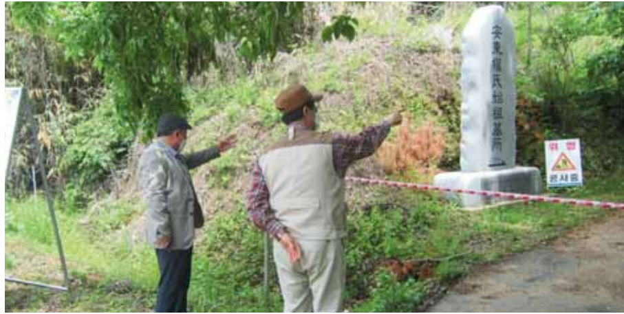
권숙동 회장(오른쪽)과 권오익 사무국장이 시조 묘소 진입로 공사 현장을 방문했다.
